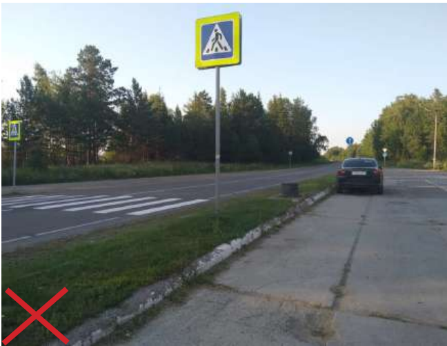
Недопустимо использовать неровное покрытие с выбоинами, ямами, разрушением наружного слоя для пешеходов, либо полное отсутствие пешеходных дорожек.
