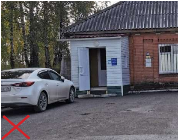
Недопустимо устраивать входную зону перед зданием без пешеходного тротуара. Следует применять ограничители движения для автотранспорта.
