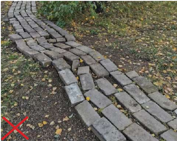
Недопустимо использовать неровное покрытие пешеходных дорожек. Плитка не должна иметь провалов и вспучивания.
