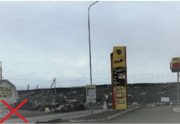
Недопустимо опору освещения совмещать с рекламными вывесками и схемой движения на АЗС.
