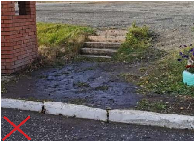
Недопустимо отсутствие покрытия для пешеходов. Необеспеченность подходов к объекту инвалидов и МГН: отсутствие пандусов, ограждений, тактильной плитки.
